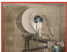
Forage de béton armé, pierre naturelle
