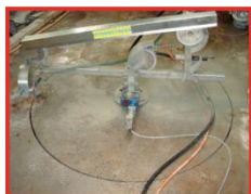
Sciage au câble
