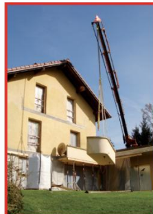
Sciage de béton armé, pierre naturelle
